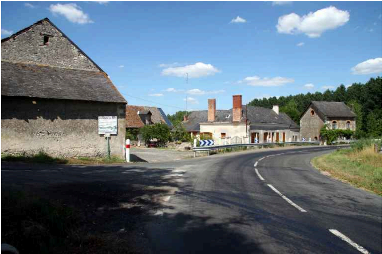
Vue d'ensemble : le moulin et la maison d'habitation.
