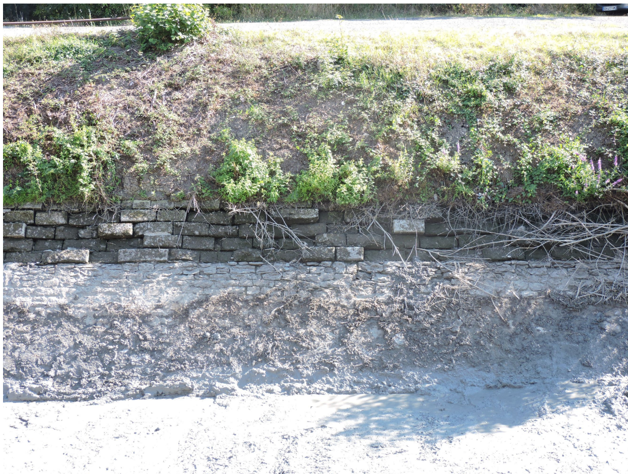
Août 2020 : bajoyers en maçonnerie sur la rive gauche du canal de Vix, en aval de l'aqueduc.
