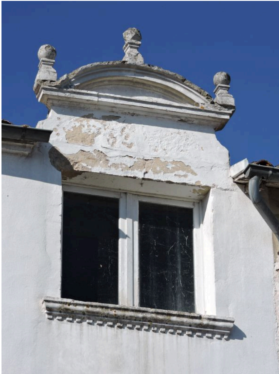
La fenêtre passante et son fronton.
