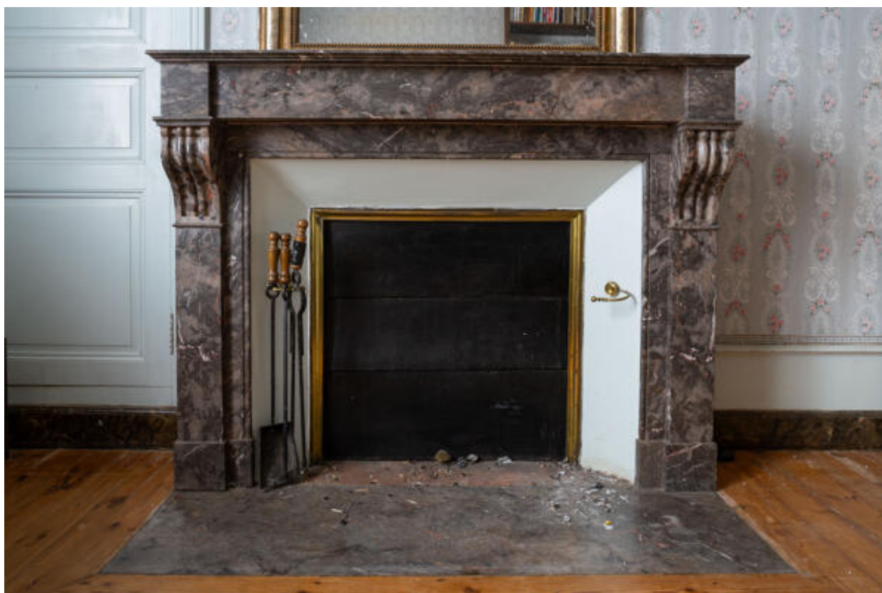
Cheminée du rez-de-chaussée (nord).
