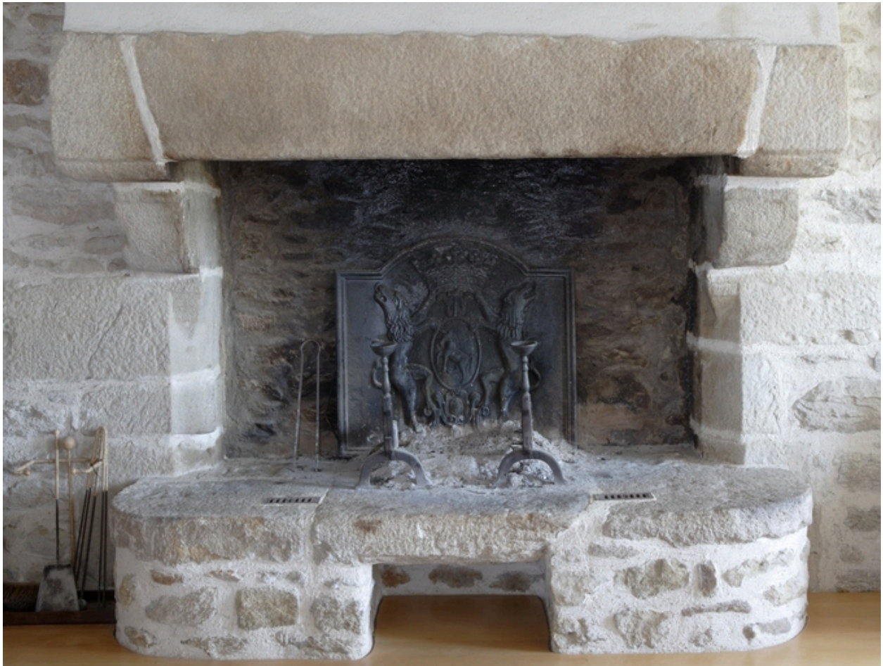
Maison n° 10 rue du Four dite Maison de la Cave. Rez-de-chaussée. Vue de la cheminée.
