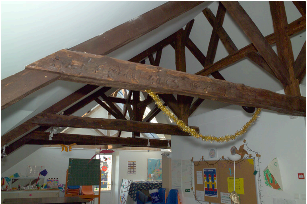
Comble, détail de la charpente.
