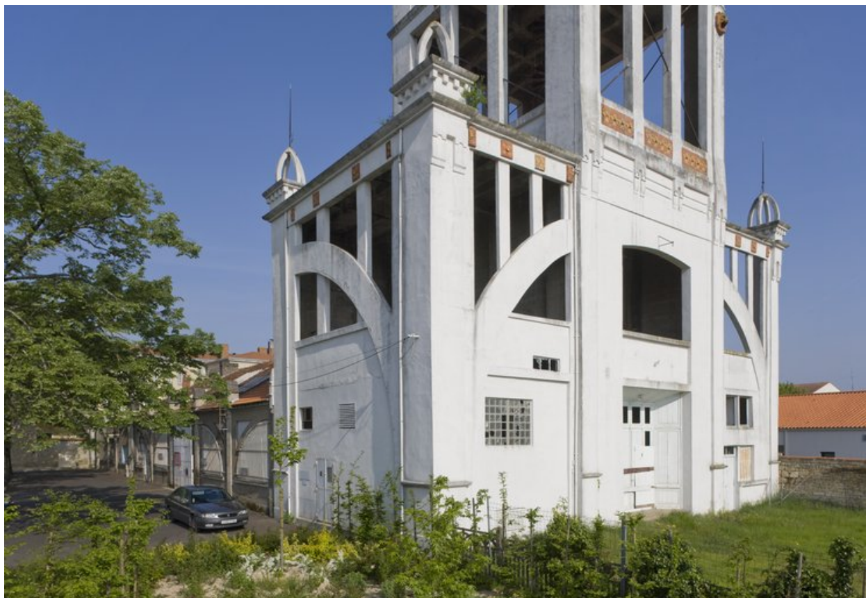
Vue du premier niveau, prise du sud-est.
