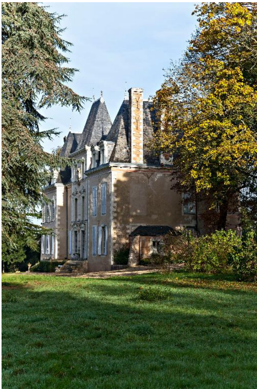
Le château vu depuis le sud : les élévations postérieure et latérale sud.
