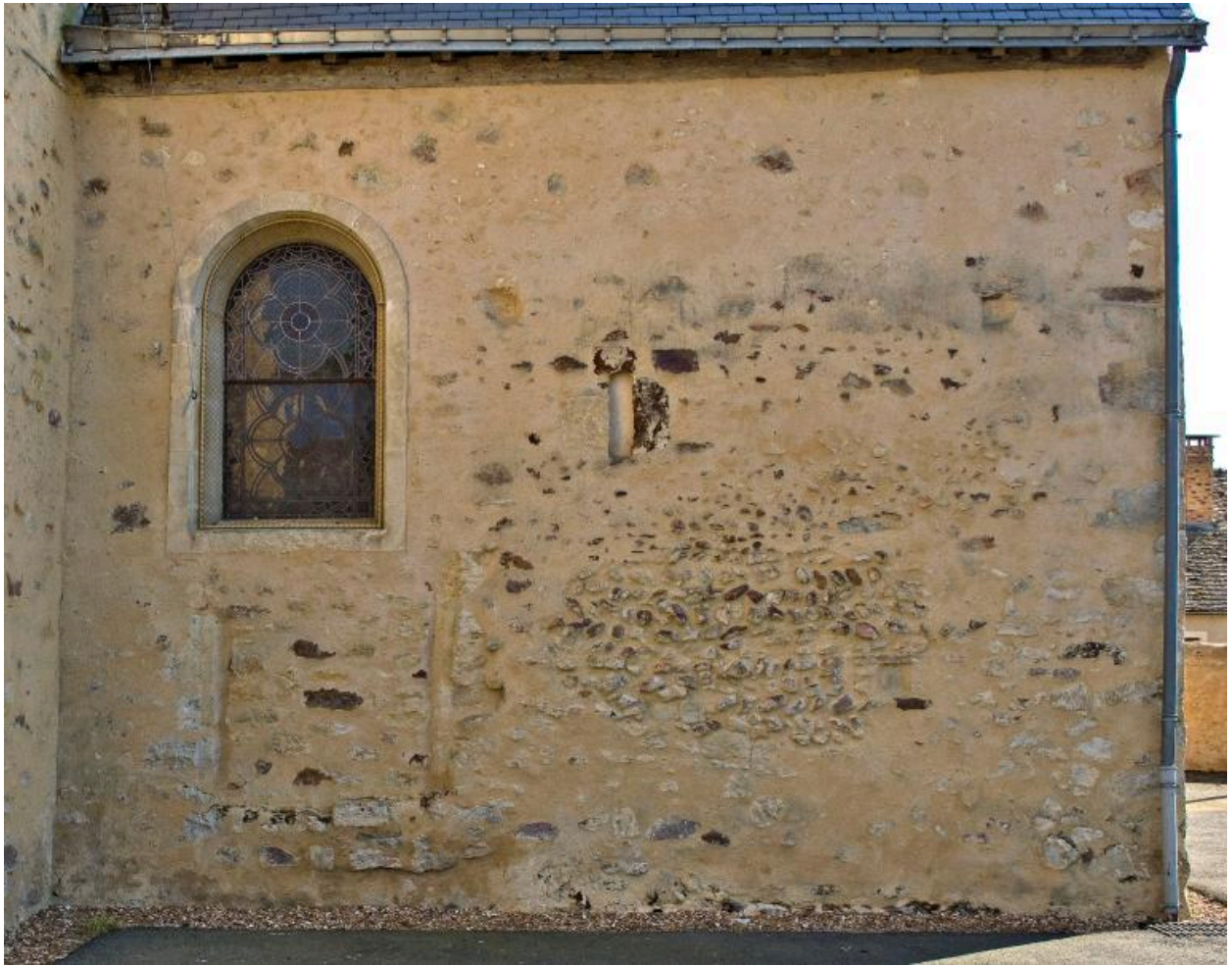
Détail du mur nord de la nef
