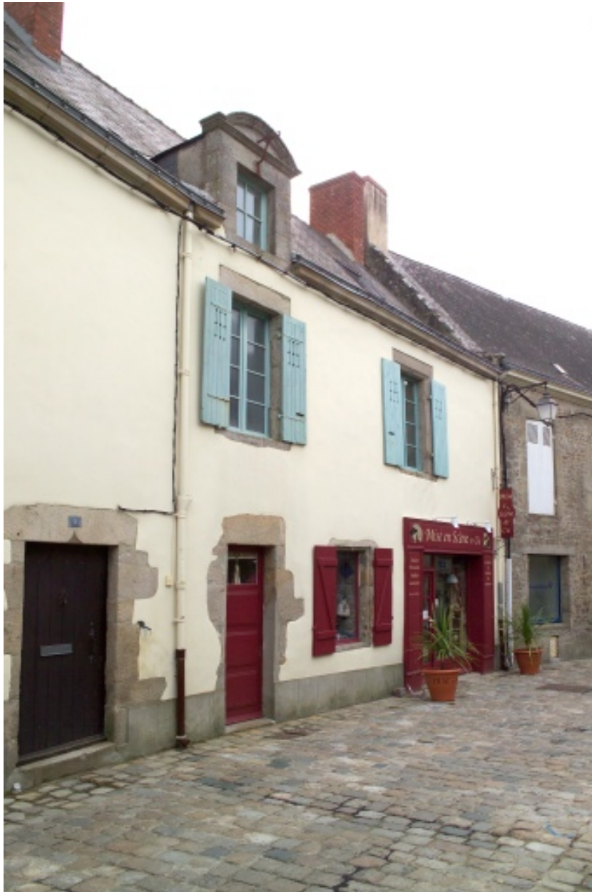
Façade sur rue, partie sud.
