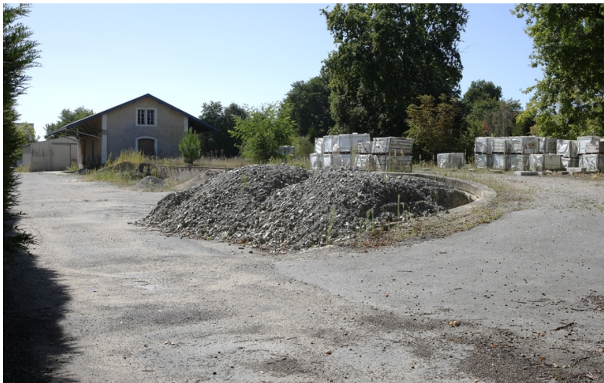
Quai de chargement.
