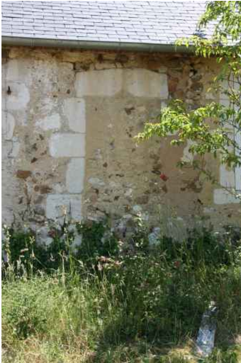
Maison d'habitation, détail : porte bouchée.
