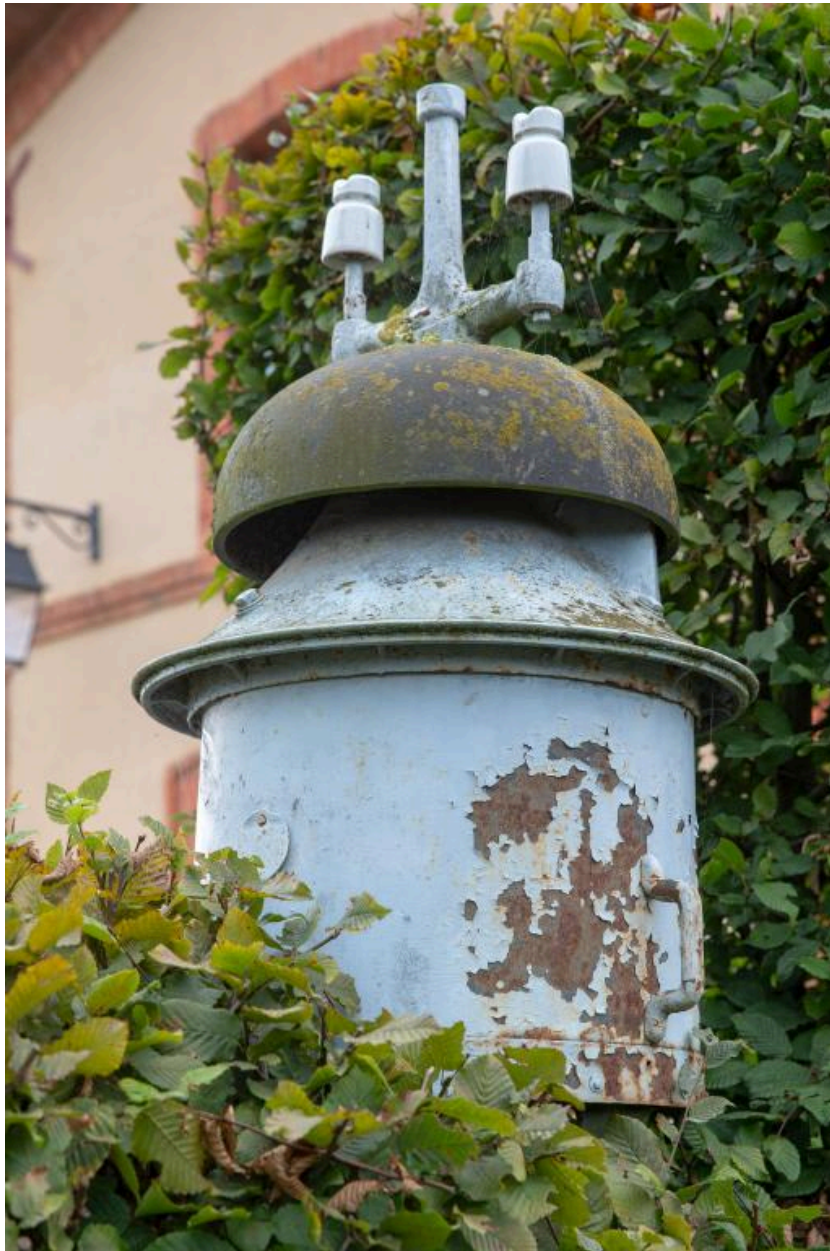
Un ancien pylône électrique.
