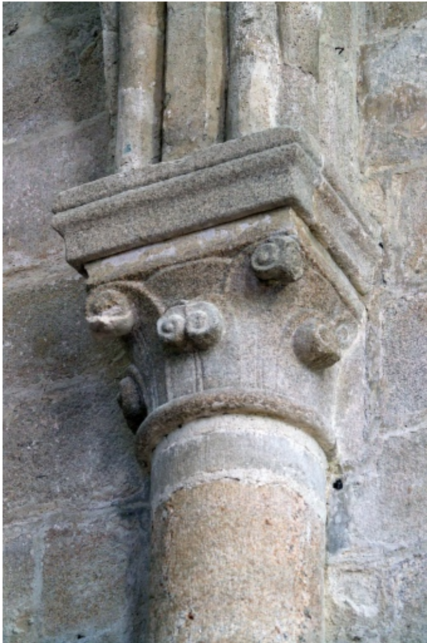
Détail d'un chapiteau de la nef.
