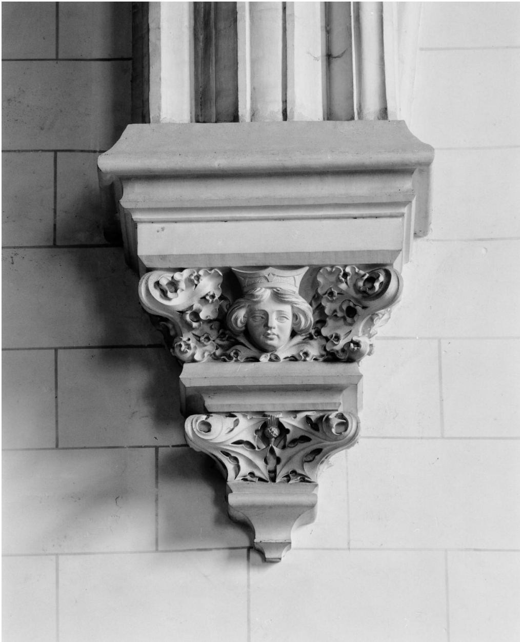
Eglise, nef, deuxième travée : culot postérieur droit (sud-est).
