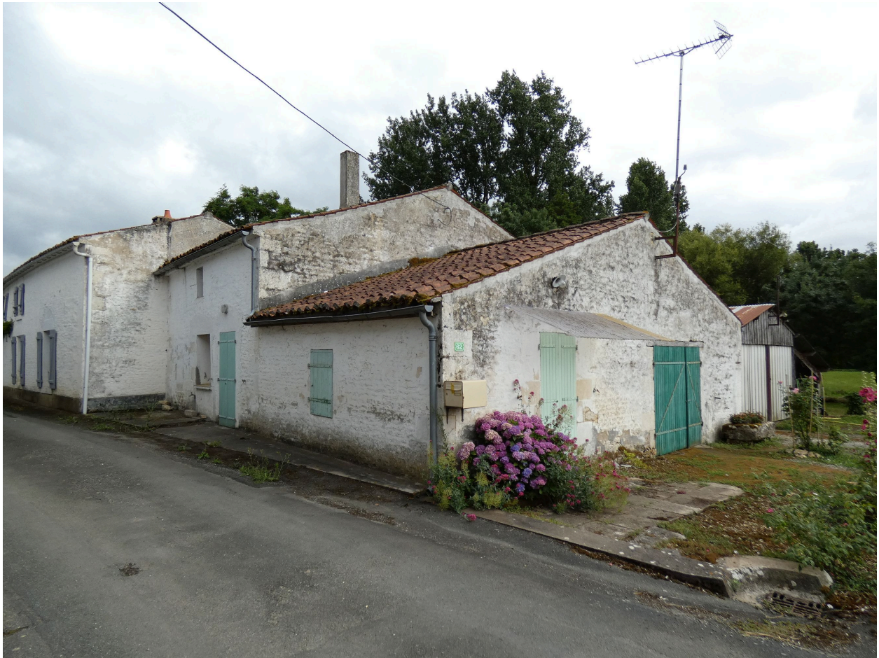
L'ancienne ferme vue depuis le nord-ouest.
