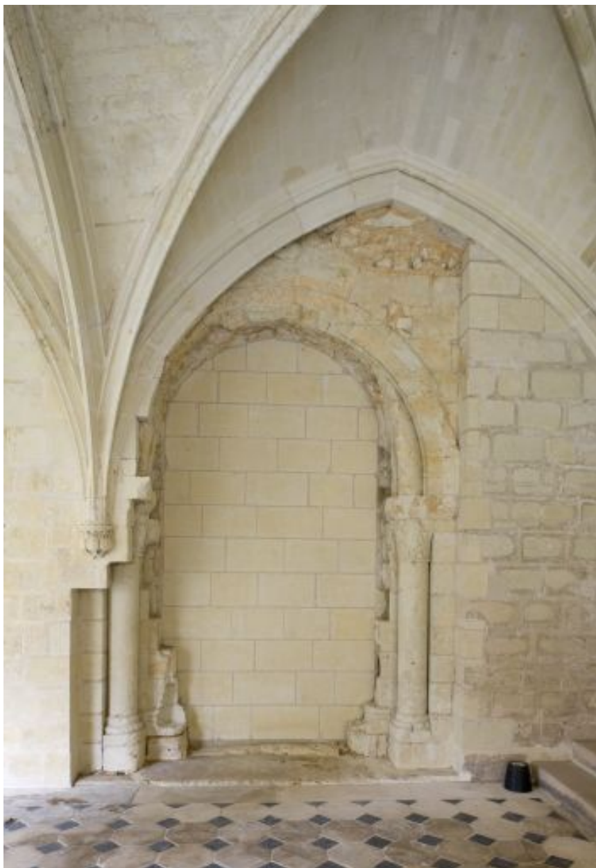
Aile sud du cloître, galerie, vestiges de maçonneries du réfectoire originel (remanié vers 1500-1520) avec une porte encadrée de colonnes à chapiteaux du XIIe siècle
