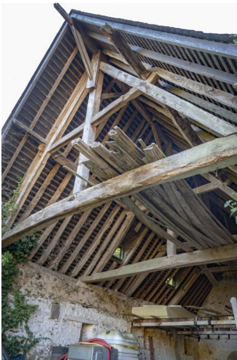
La charpente de la grange.
