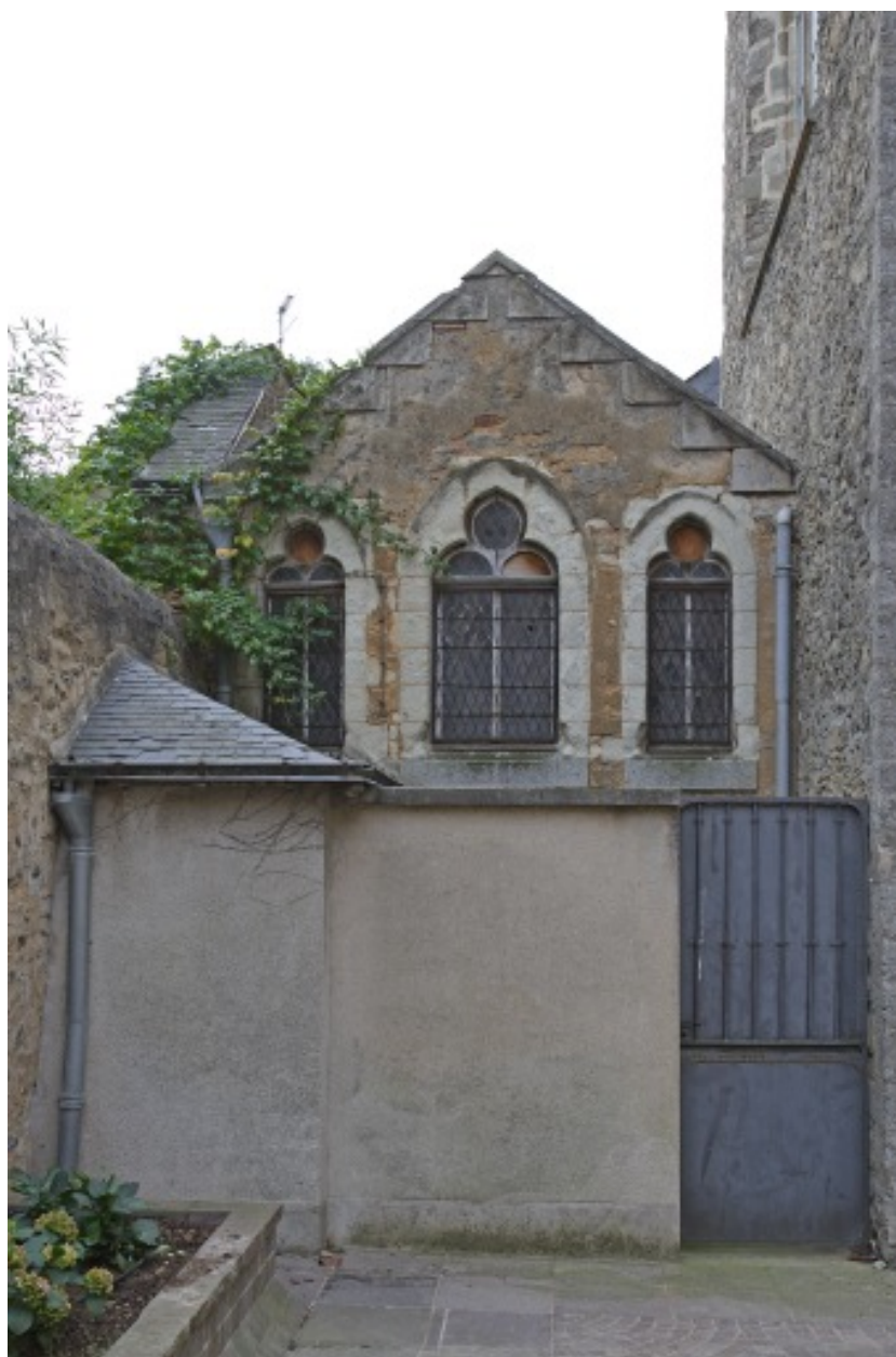
Chapelle de semaine, élévation antérieure : vue d'ensemble.
