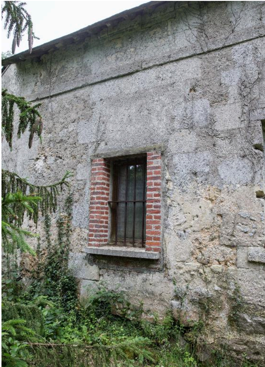
Logis, façade postérieure : vestiges d'une travée de baies.
