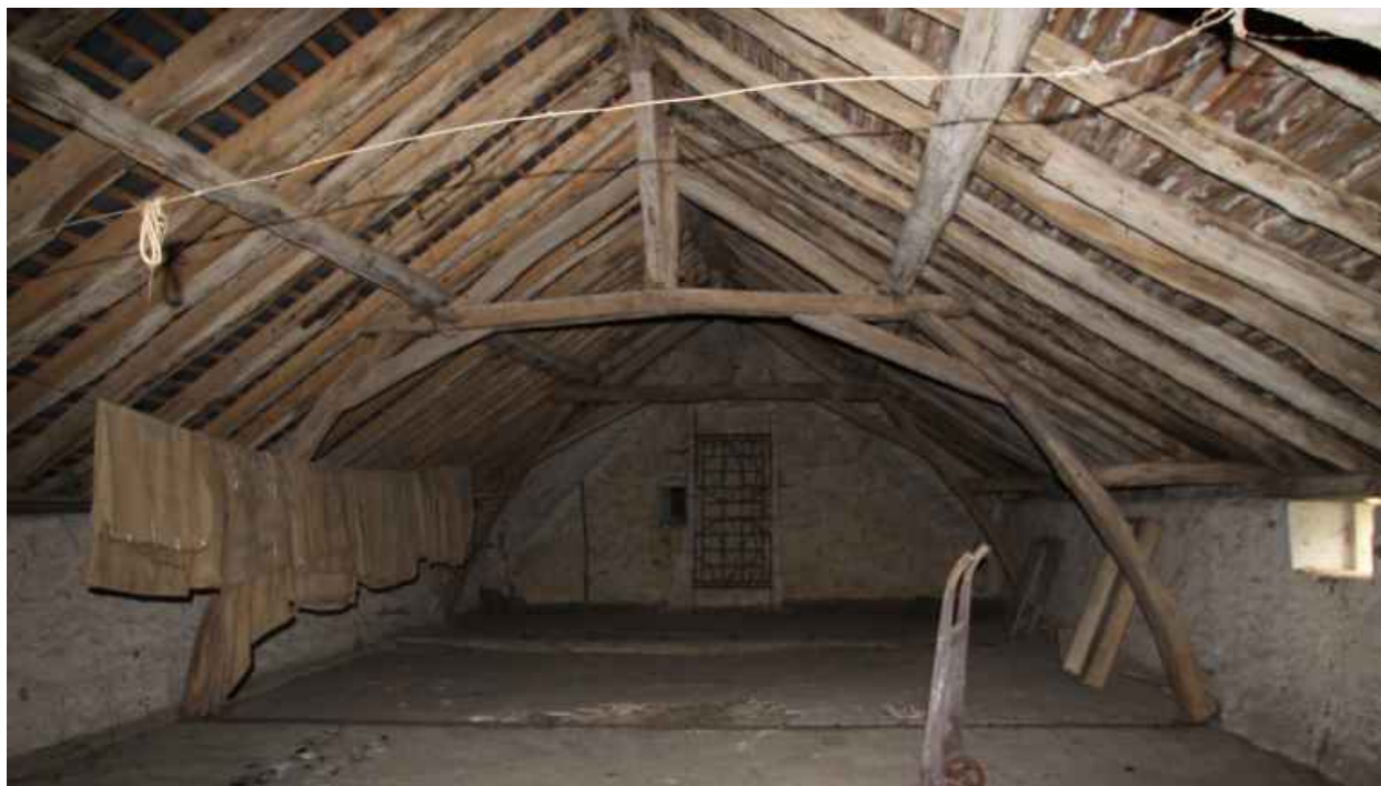
Combles à surcroît des étables : charpente à pannes.
