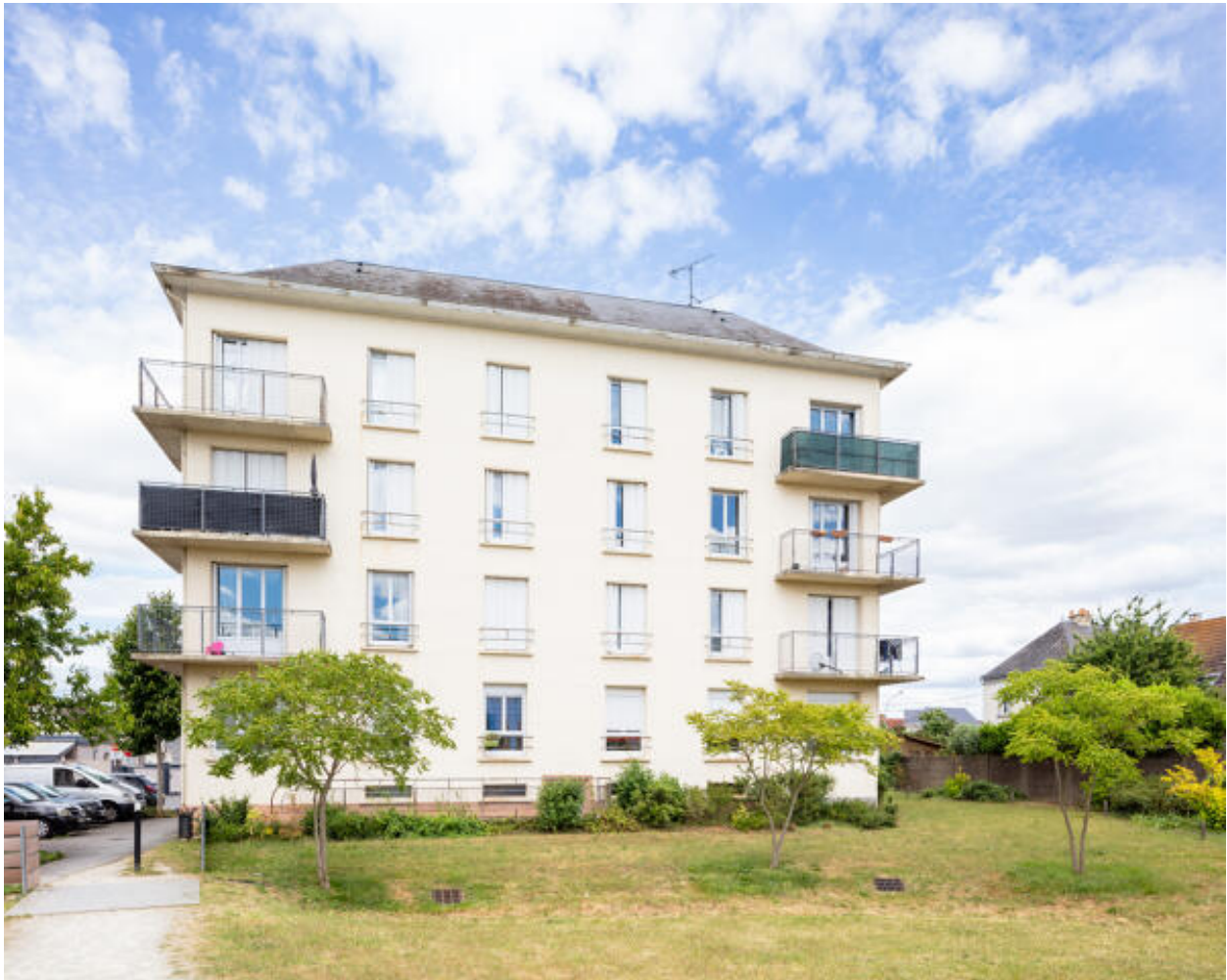
Vue de la façade arrière du bâtiment H rue des Bigarreux.
