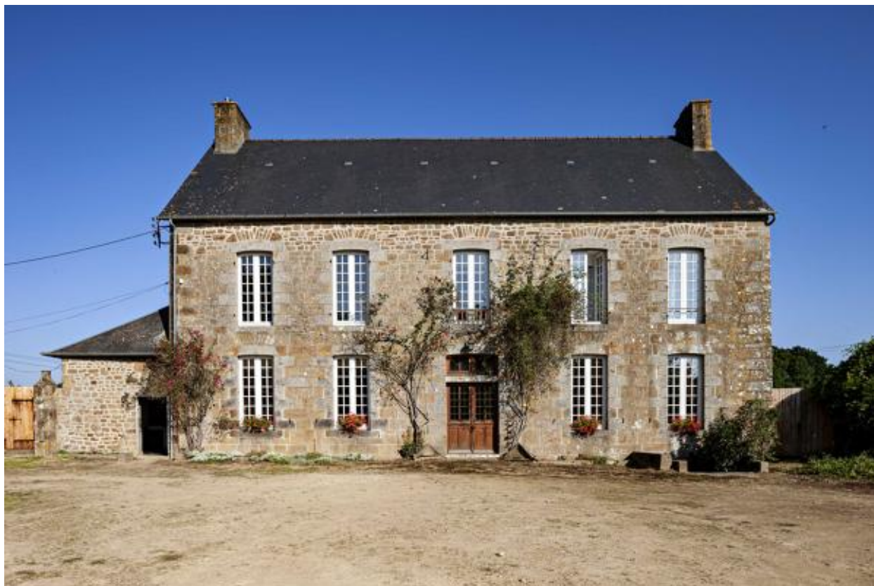
Maison de maître, façade sud.
