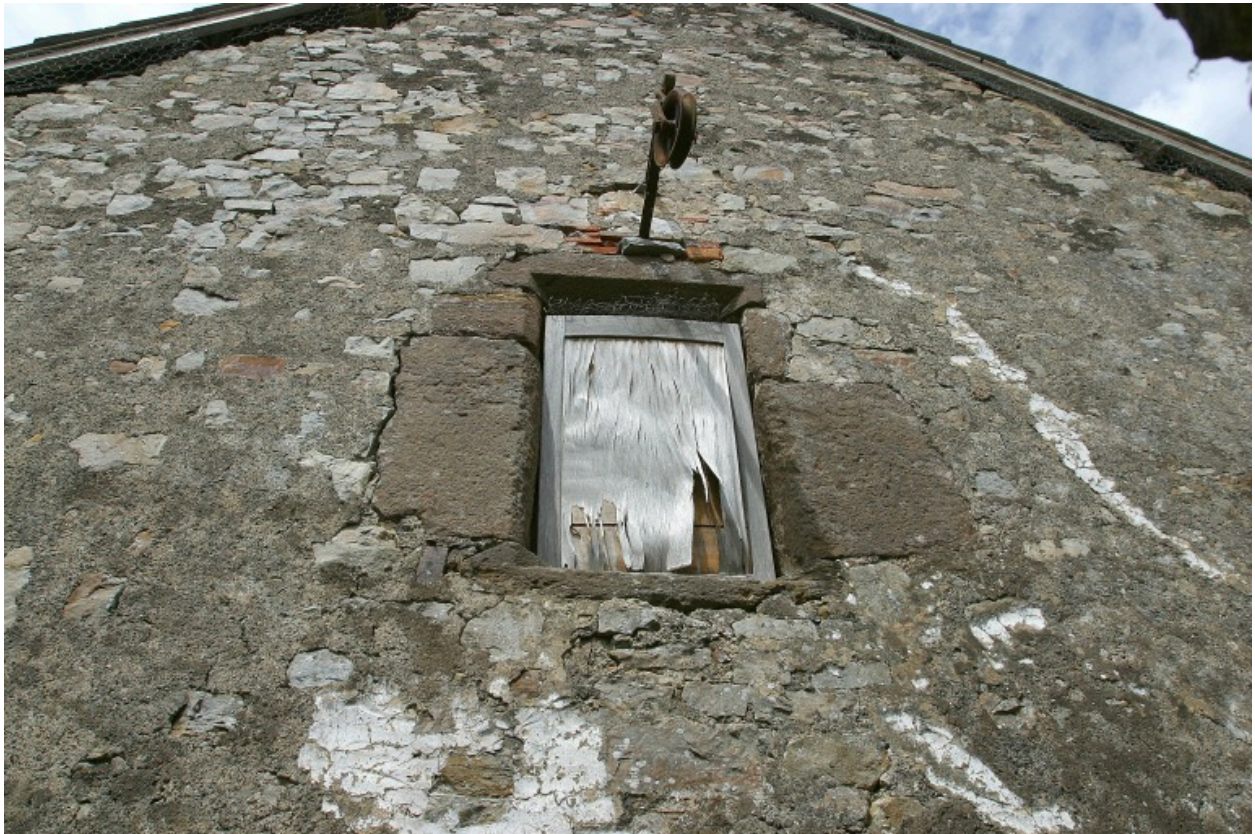
Détail de l'élévation sud : la fenêtre ouvrant sur le comble.
