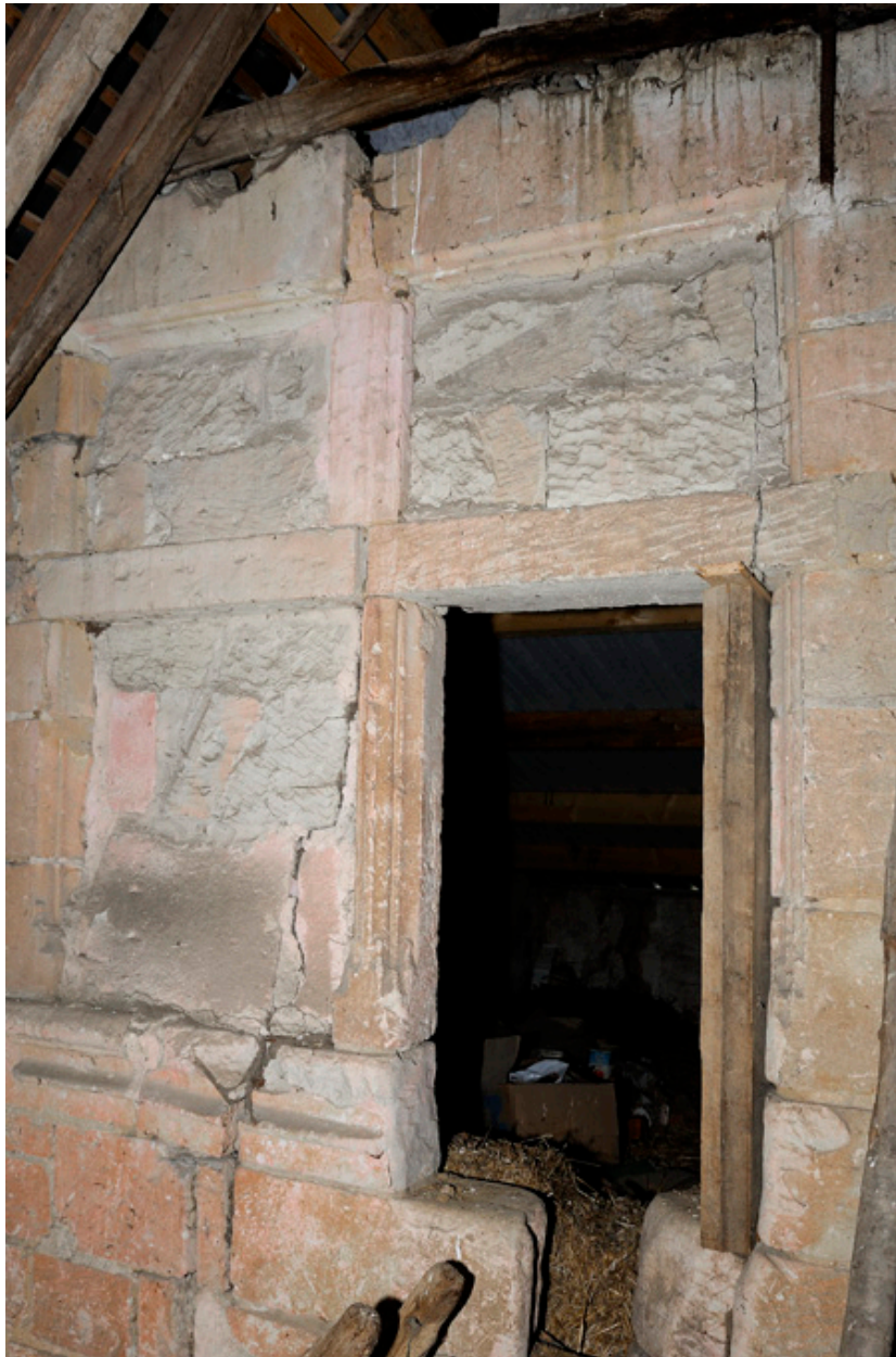
Etage, salle est : croisée nord (vue 1).
