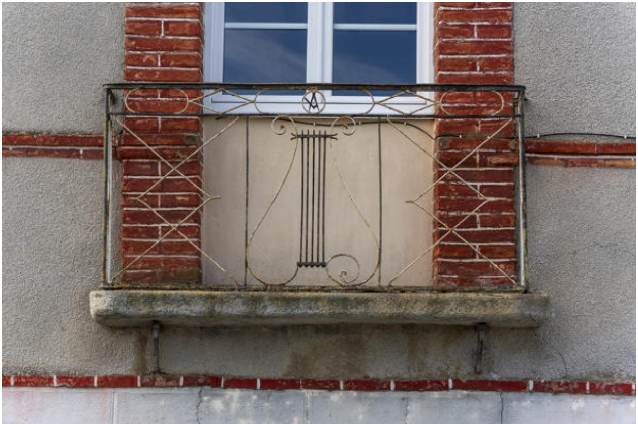
Un détail du balcon.
