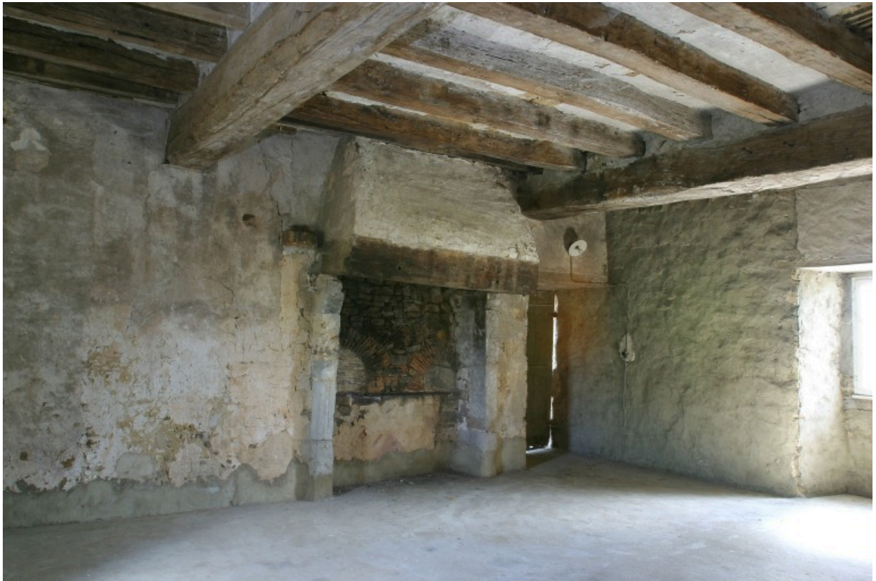
Rez-de-chaussée surélevé. La pièce 4B vue depuis l'angle sud-ouest.
