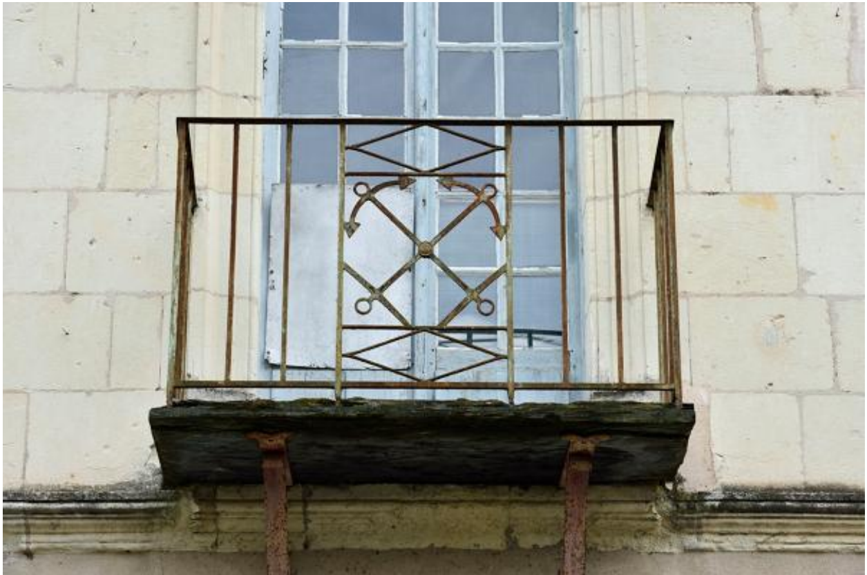
Denée. Port-Godard. Détail d'un balcon en fer forgé orné d'une ancre.
