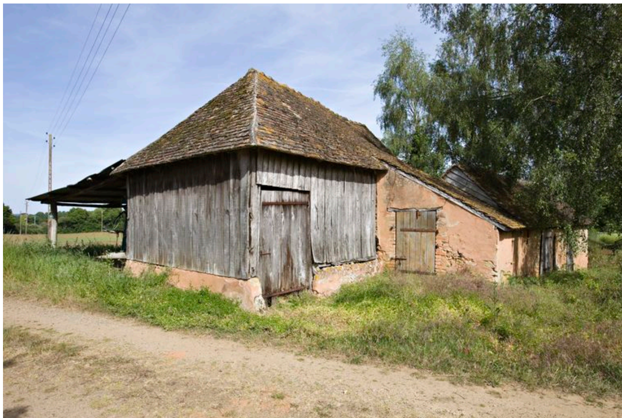
Fournil converti en remise.
