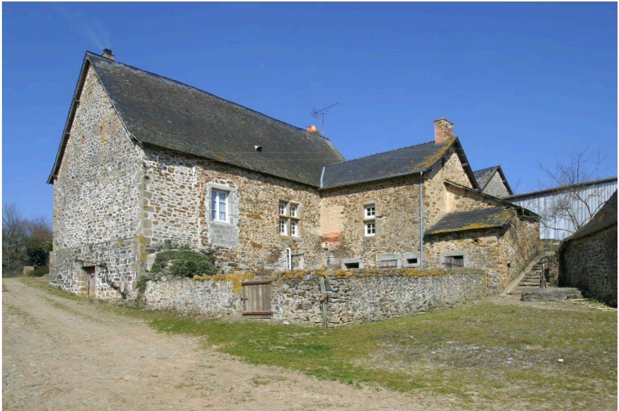
Le logis vu depuis le sud-est.
