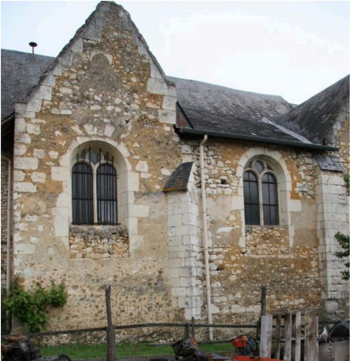
Bas-côté sud : façade.
