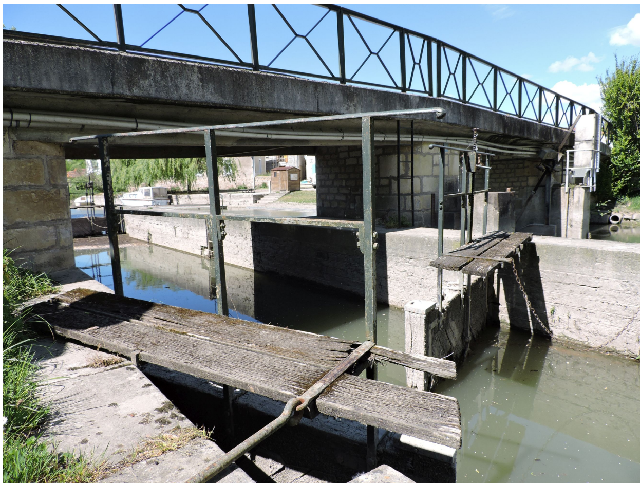
La porte amont de l'écluse.
