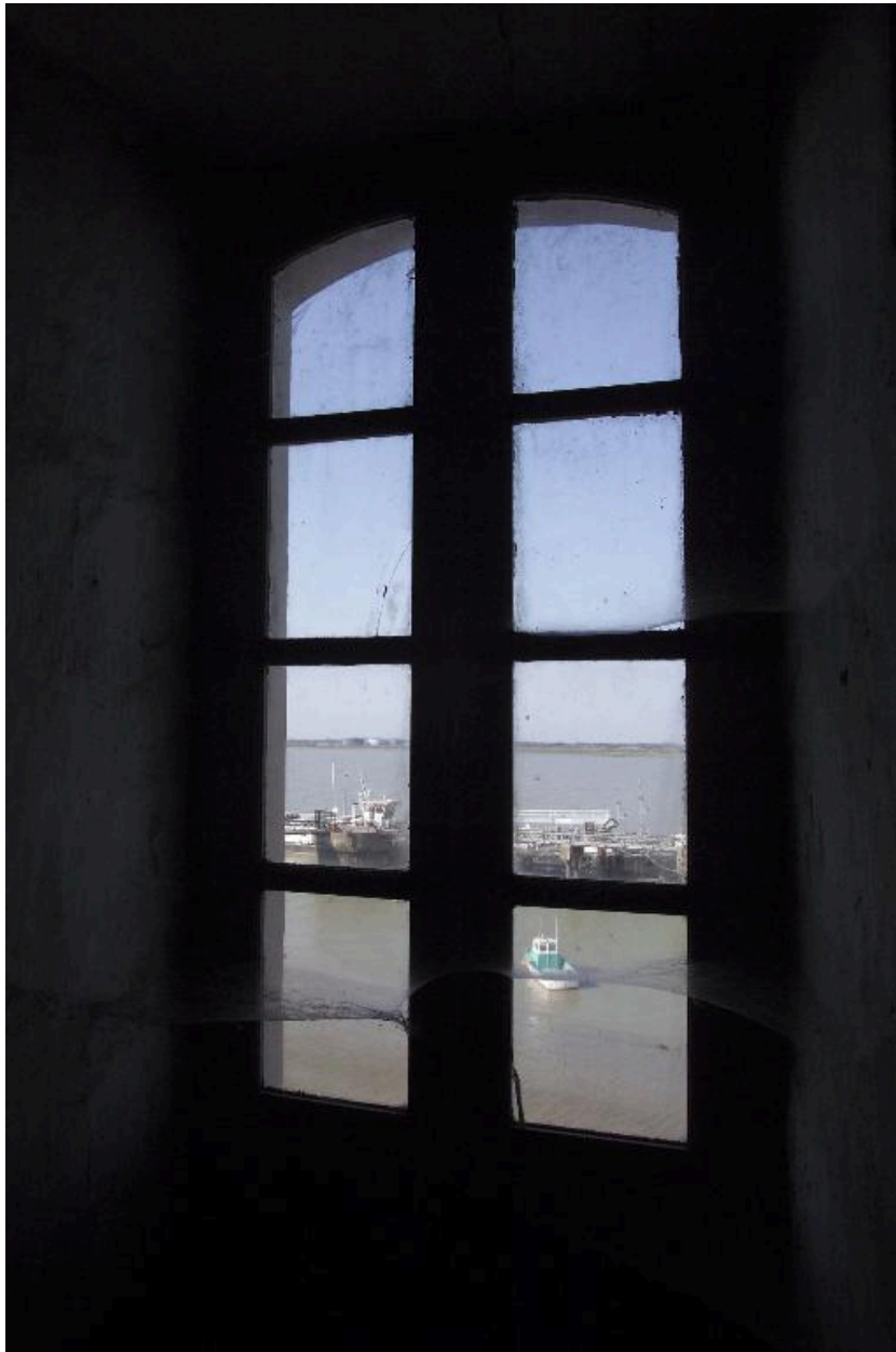
La pièce du deuxième étage du côté du quai, détail.
