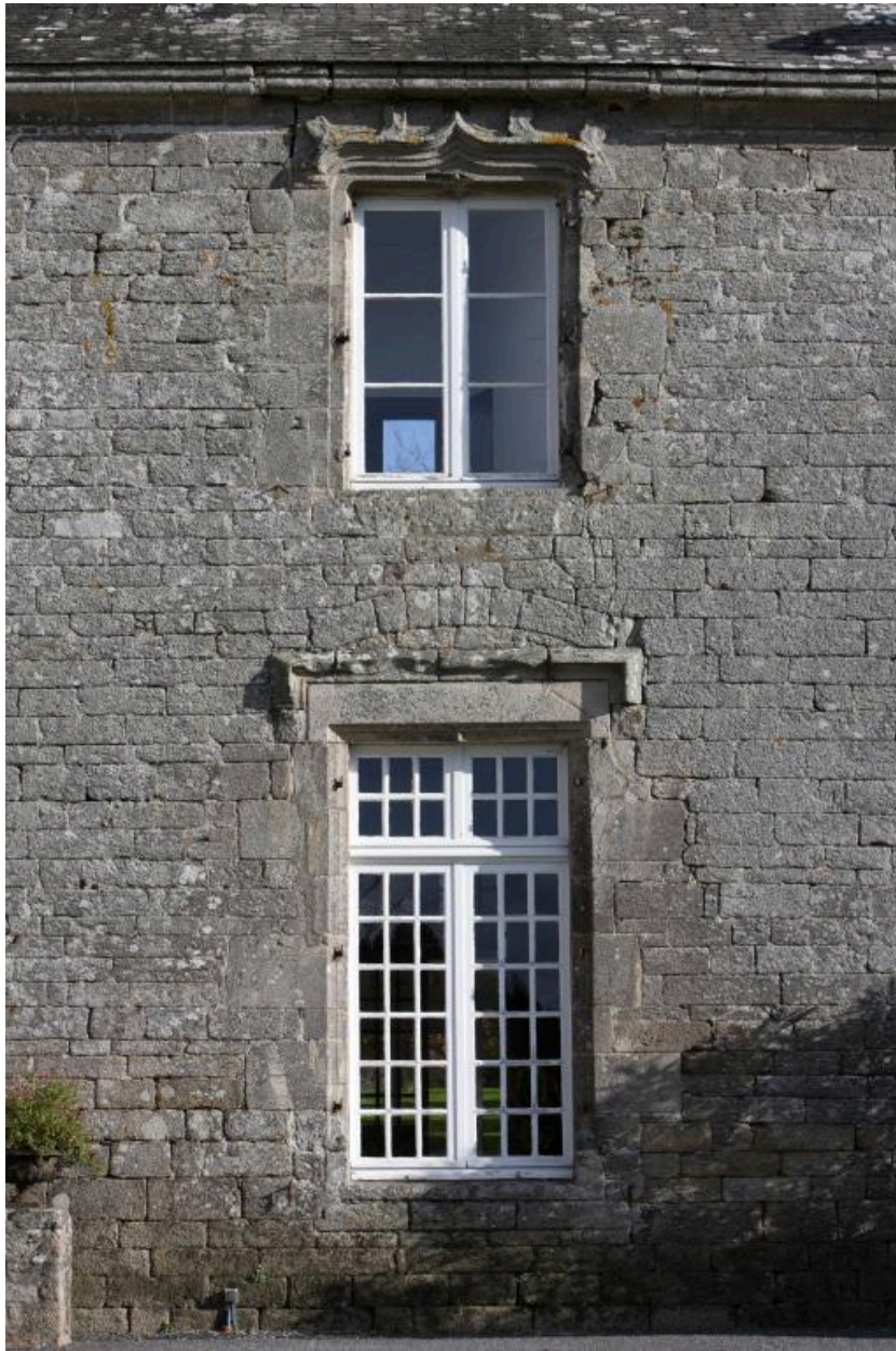
Logis. Aile est. Détail de la travée de baies.
