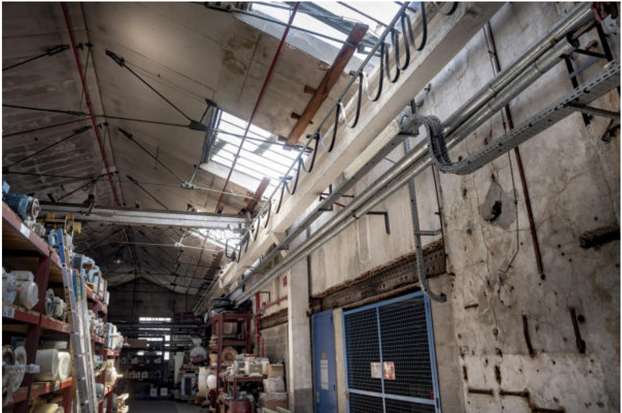
Vue intérieure de l'ancien bâtiment des cuves puis de la machine à papier (A2 du plan).
