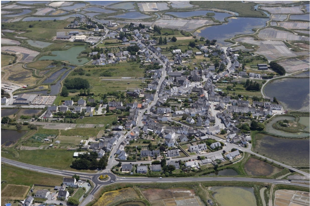
Vue aérienne depuis l'ouest.
