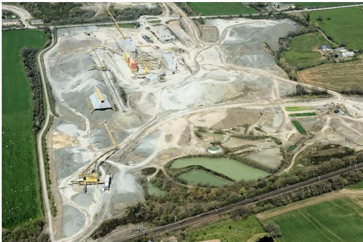
Vue aérienne de la centrale à béton.
