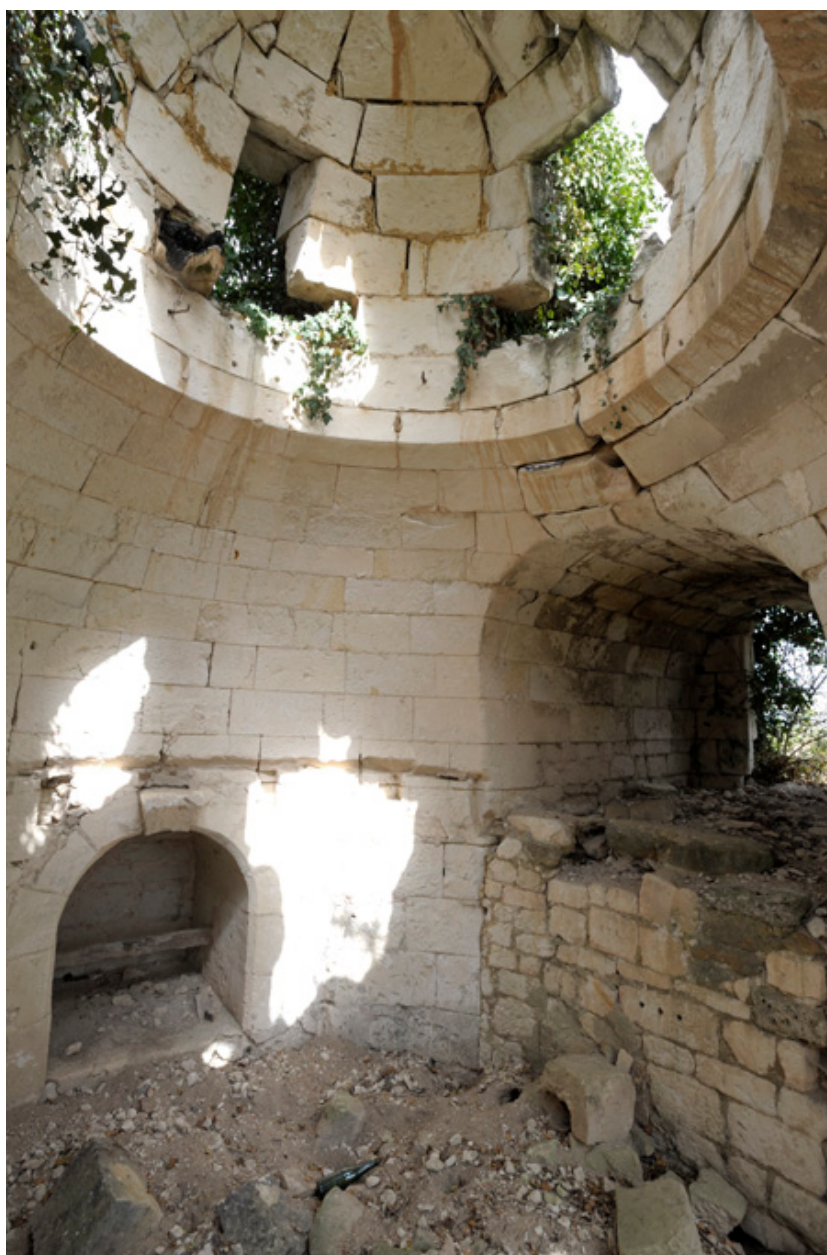
Salle des meules, vue d'ensemble.
