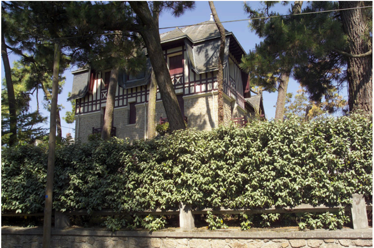
Vue d'ensemble de la villa Ker Irène.
