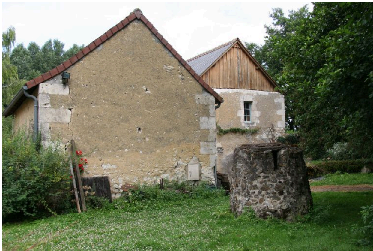
Le puits et le pignon arrière de la remise.
