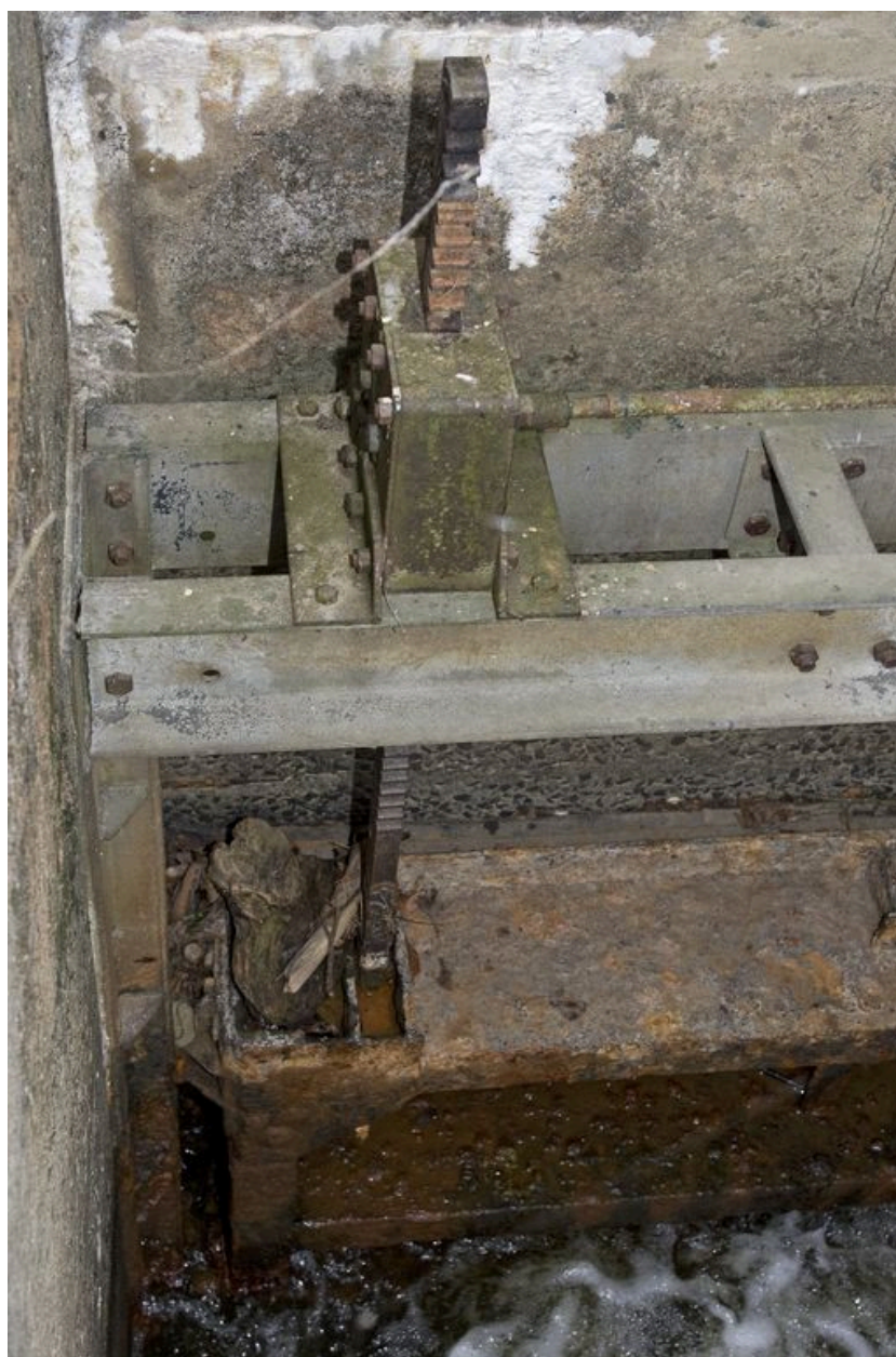
Détail de la vanne et des crémaillière d'une des portes de l'écluse pendant les écourues de 2009.
