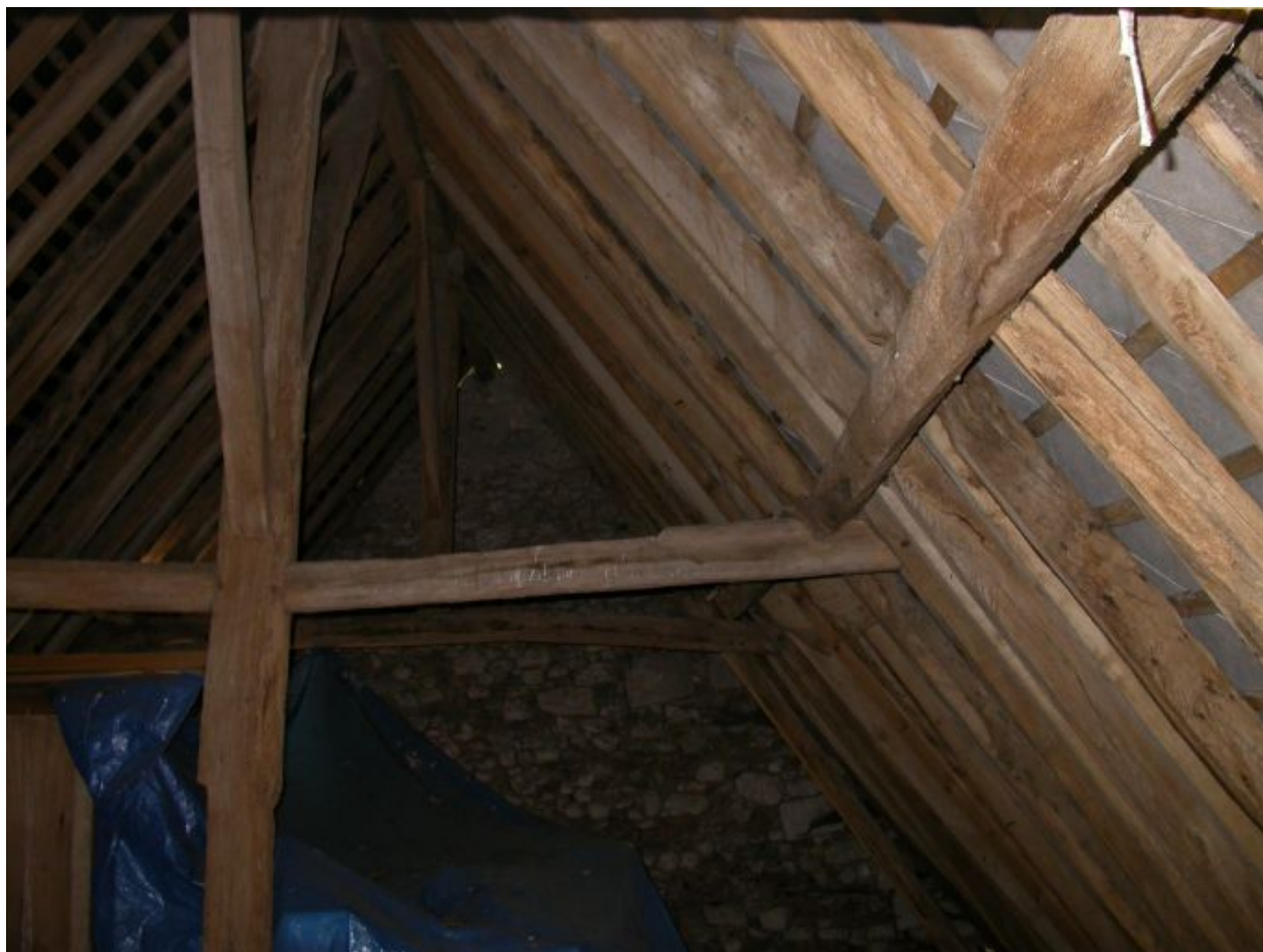
La grange : charpente à pannes avec encoches dans le faux-entrait.
