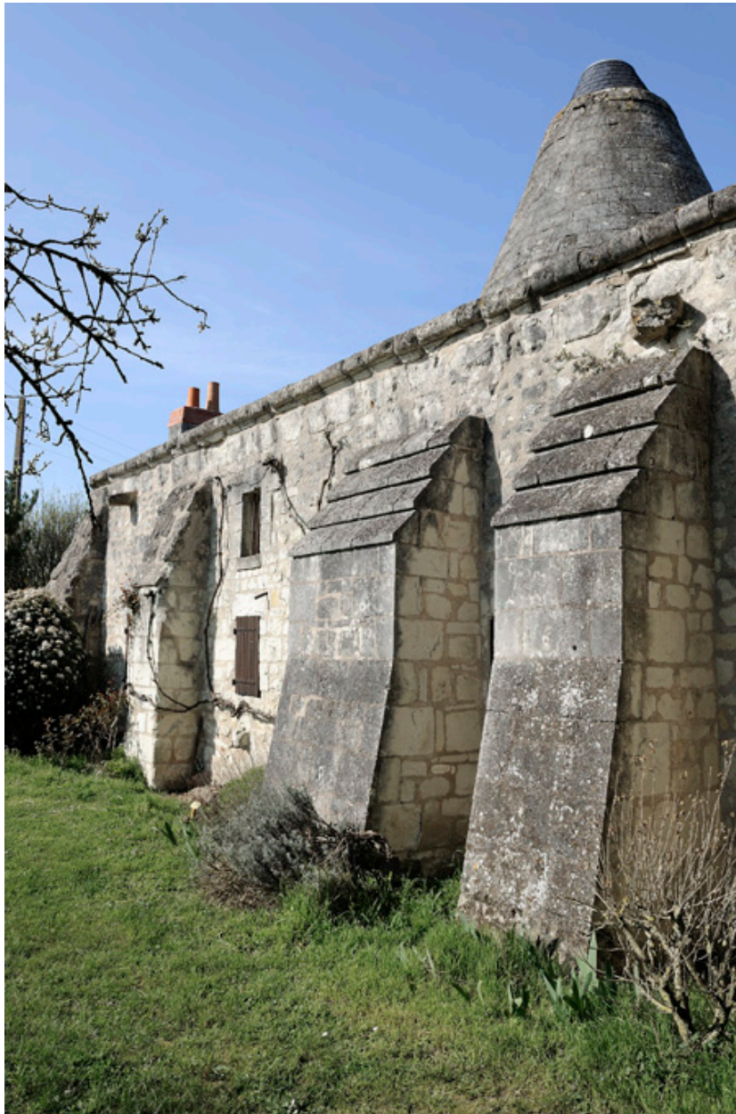
Moulin Neuf : contreforts de la façade sud
