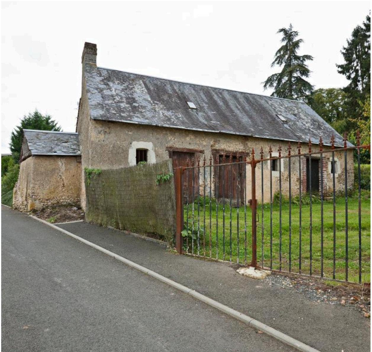
Dépendance, avant restauration.
