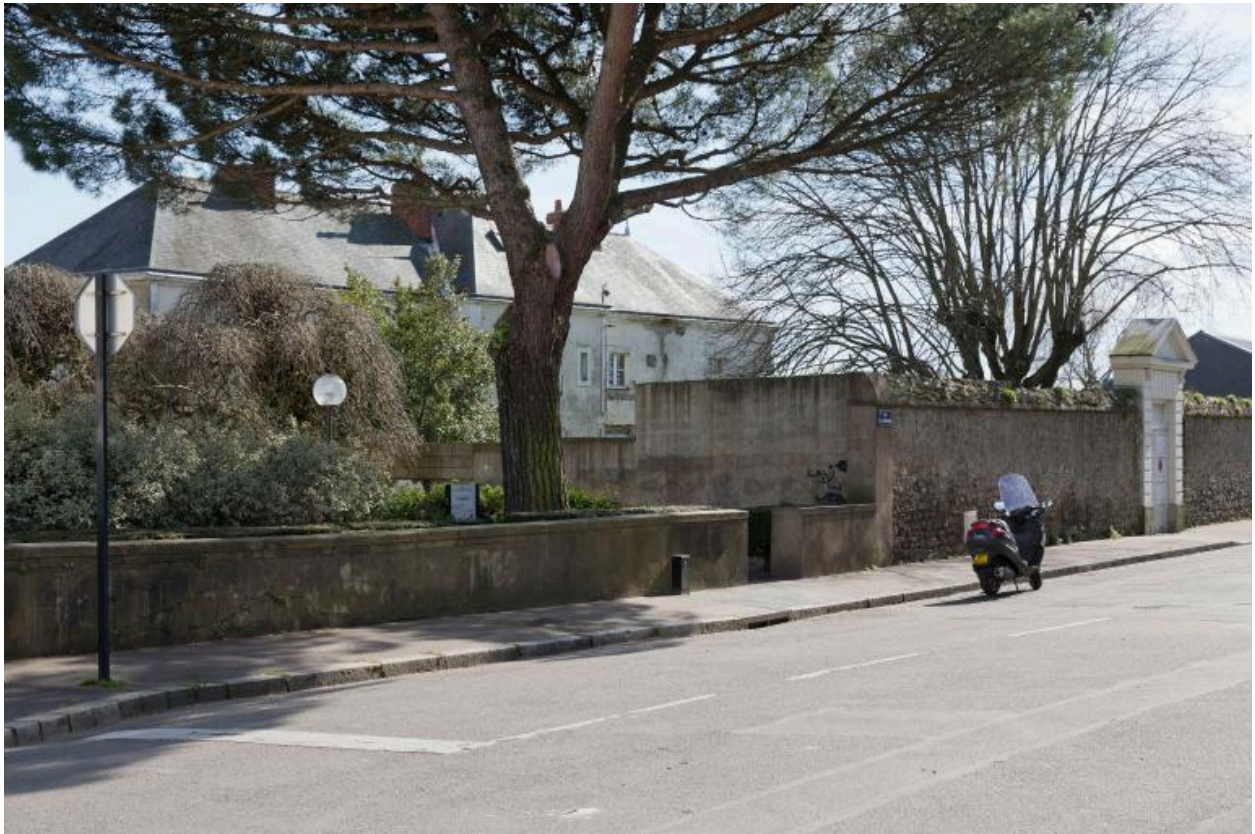
Mur de clôture, rue de l'Hermitage.
