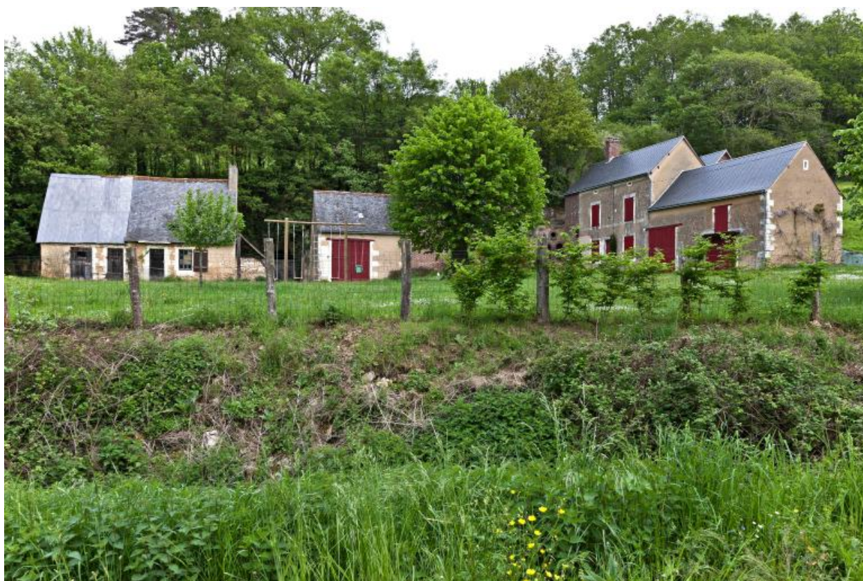
Vue du site bâti, depuis le sud.
