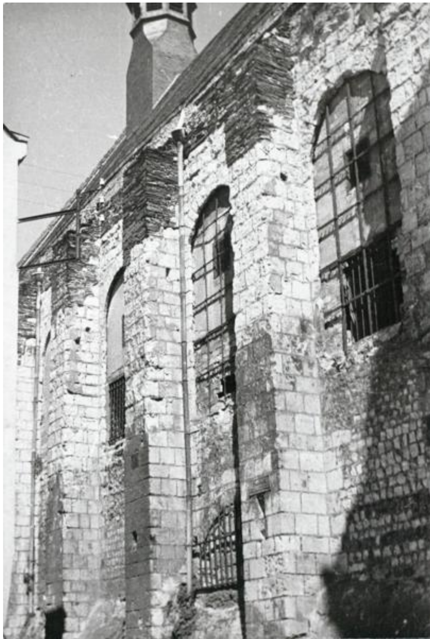
Eglise abbatiale, élévation extérieure sud : détail sur les baies occidentales et contreforts, fotogr., de H. Enguehard, [v. 1960]. (Coll. part., Henri Enguehard).
