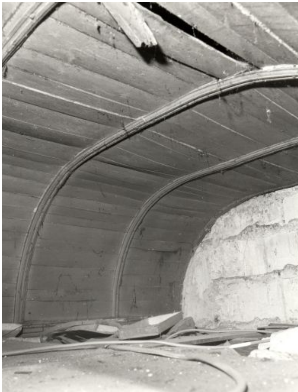
Oratoire, voûte du 1er étage : détail antérieur droit de l'intrados.
