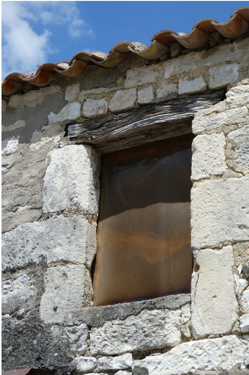
Baie à encadrement chanfreiné sur la dépendance, ancienne chapelle.
