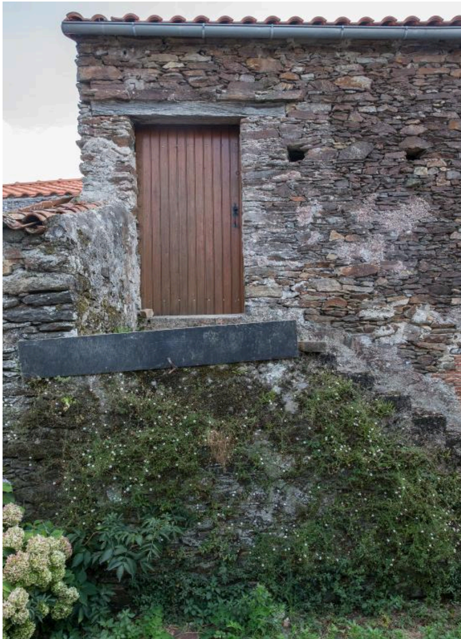
Corniche de pierre au-dessus d'une porte. Pé de Sèvre, Le Pallet, cadastre 2018, BM 01-473.
